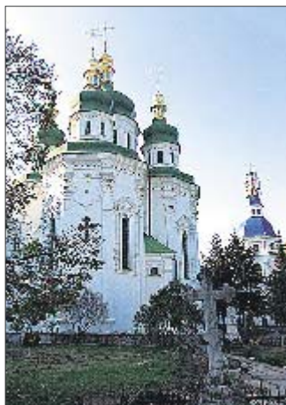
Монастырь пошел трещинами
